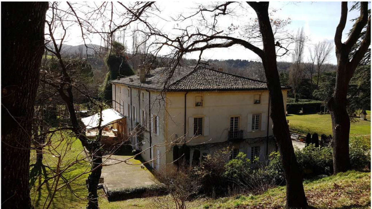
Façades Nord et Est
