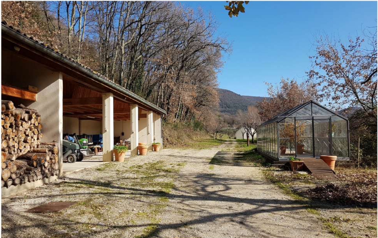
Hangard à tracteurs + verrière
